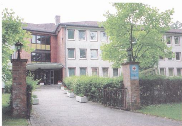
ISD Hauptgebäude Frontansicht
