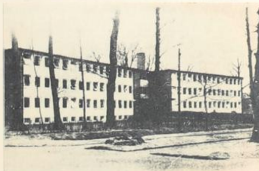
Erstes Gebäude im modernen Stil war der Neubau für den Internationalen Suchdienst in Arolsen, der bis 1952 in der jetzigen belgischen Kaserne sein Domizil hatte. Seit der Errichtung des dreiflügeligen Bauwerks wurden hier weit über 1,5 Millionen Such- und Auskunftsanträge aus aller Welt bearbeitet. (vg/Aufnahme: yg)
