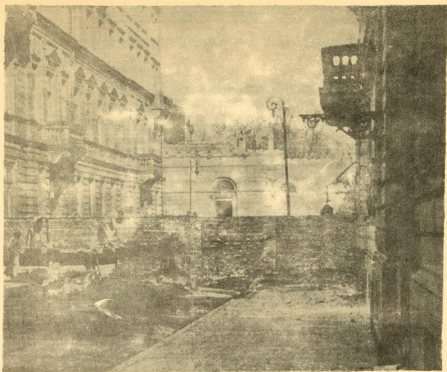
Ghettomauer im Bau
