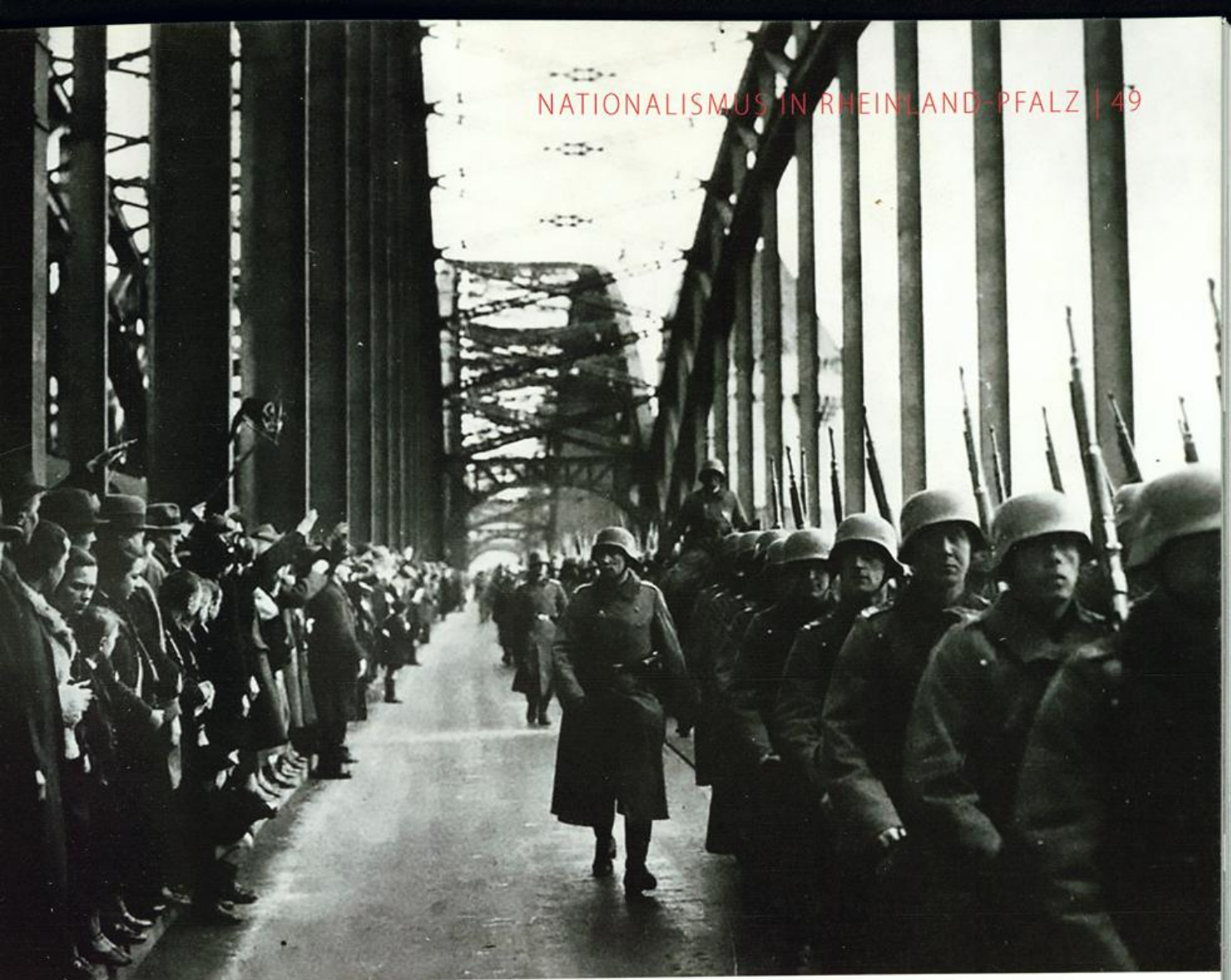
Wehrmacht marschiert über die Rheinbrücke [Abb. 50]
